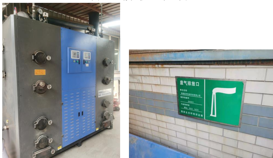
图 3-4 废气排口标志牌
